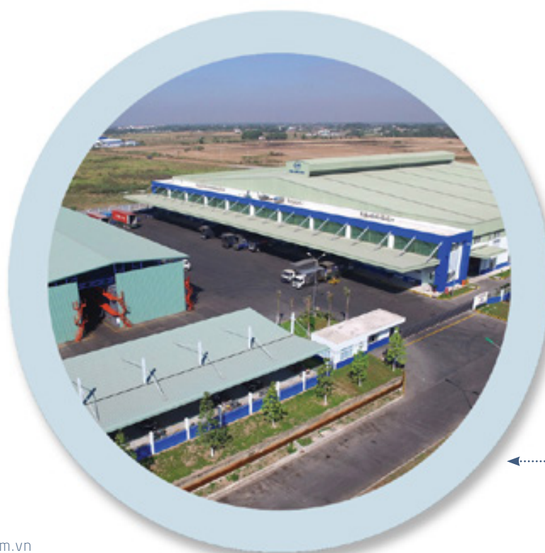
NHÀ MÁY LONG AN
